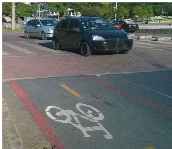
Fig.4 Interrupção da ciclovia na travessia elevada na Avenida Otacílio Negrão de Lima
